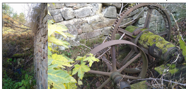
Pôvodný náhon Dolného mlyna. Vpravo podlaž z vonku (ešte zachovaná os mlynskeho kola), vľavo pohľad z druhej strany steny.
